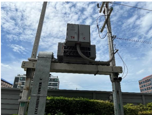
หม้อแปลงไฟฟ้าอาคาร C
